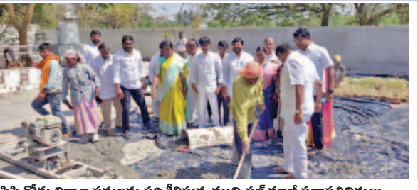
సిసి రోడ్డు నిర్మాణ పనులను పరిశీలిస్తున్న మున్సిపల్ మాజీ ప్రజాప్రతినిధులు
